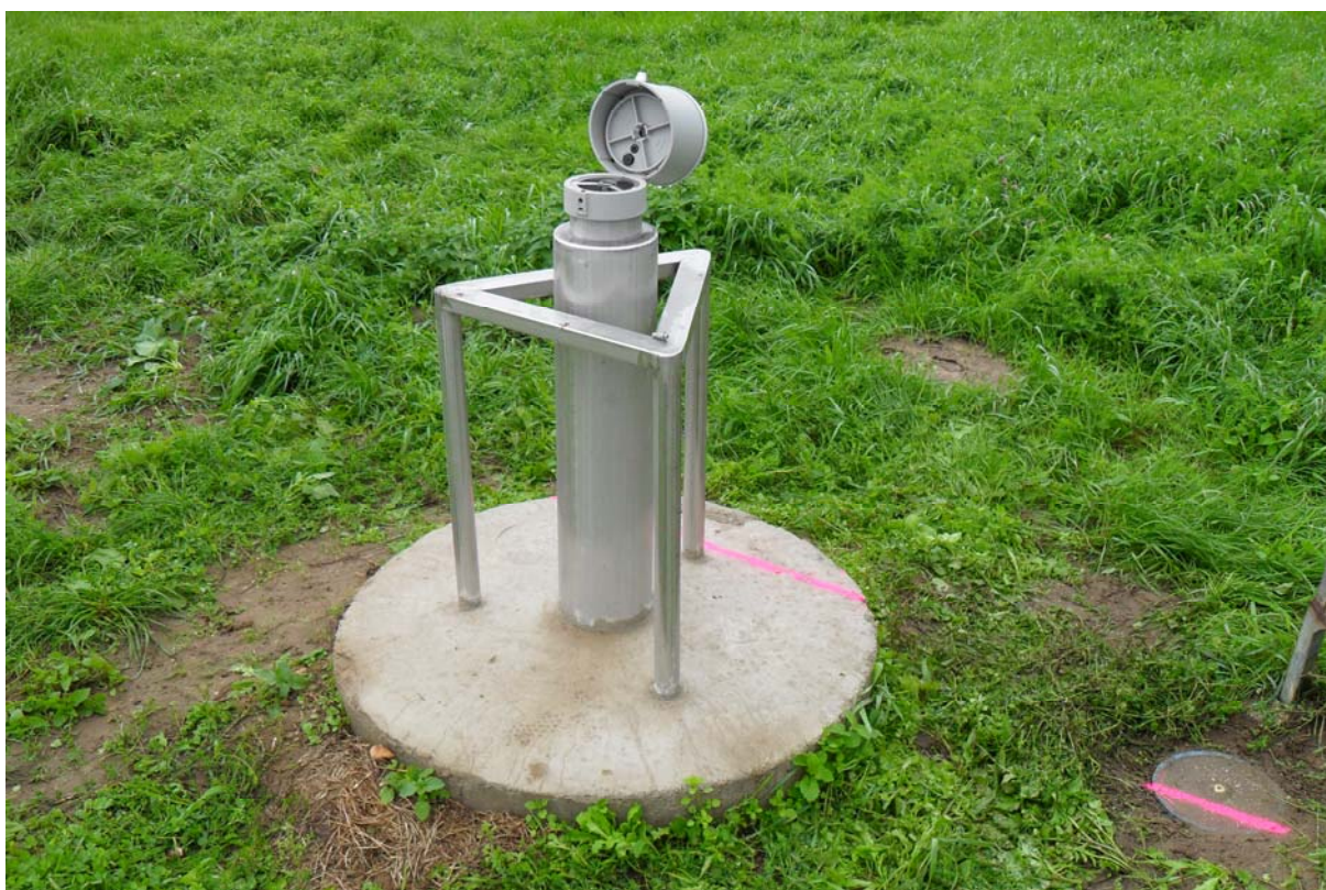
Abbildung 3: Grundwassermessstelle mit Höhenkontrollpunkt
