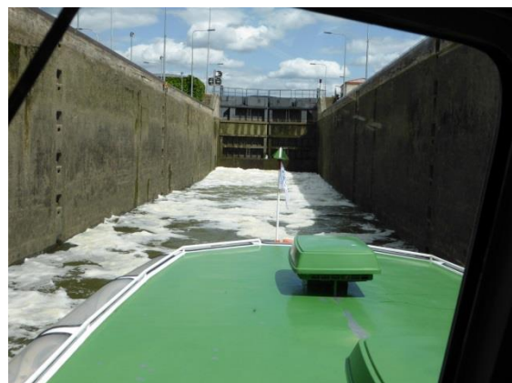
Schleuse wird geflutet
