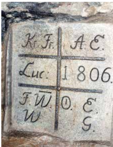
Abbildung 7: Markscheidestufe aus dem 19. Jh. zur Markierung der Grubenfeldgrenze zwischen den Grubenfeldern „Alte Elisabeth“ („A.E.“) und „Krieg und Frieden“ („Kr. Fr.“). Vermessen und angebracht im Quartal Luciae (d. h. 4. Quartal, vom 1. Oktober bis 1. Januar) des Jahres 1806. Darunter stehen die Initialen der Verantwortlichen der beiden beteiligten Gruben, nämlich für Krieg und Frieden Obermarkscheider Freiesleben, Obereinfahrer Wagner, Schichtmeister Wiedemann, und den entsprechenden Bergbeamten der anderen Grube: Oelschlägel, Engelschall, Goldberg. 10 Foto: Marcus Wandinger, 21. September 1990
