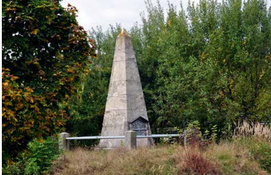
Abbildung 13: Pyramide zur Markierung des südwestlichen Endpunkts der 1801 gemessenen Basislinie zwischen München und Aufkirchen der ersten bayerischen Triangulation. Foto: Marcus Wandinger, 8.10.2009
