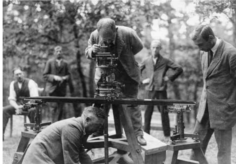
Vermessung mit Basisapparat des Geodät. Instit. Potsdam 1924, © Deutsches GeoForschungsZentrum GFZ
